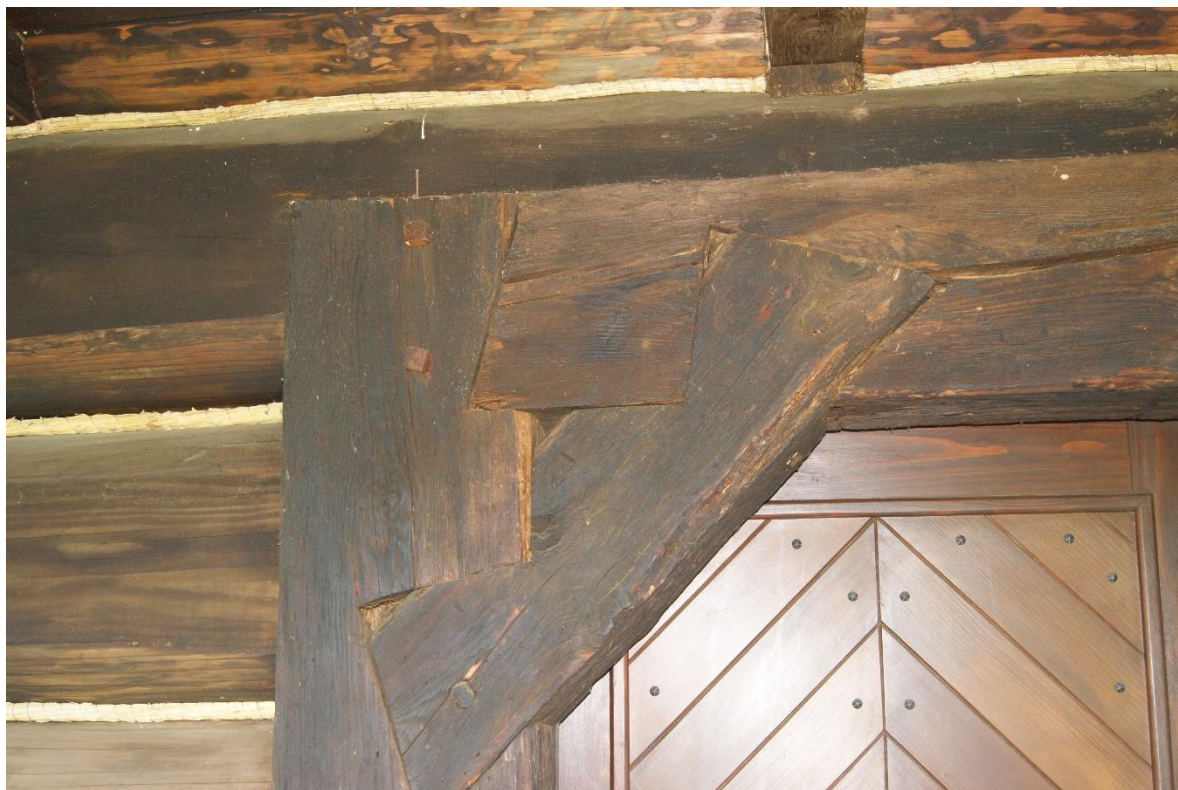
Fot. Portal drzwiowy parteru budynku spichlerza plebańskiego z Rożnowic z k. XVIII w. z zastrzałami w narożach w formie tzw. piesków .
