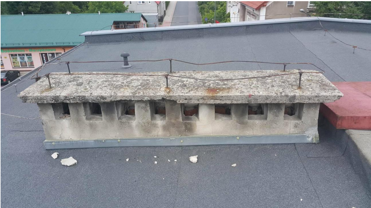
Rys. 4 Zaleca się zabezpieczenie otworów poprzez zastosowanie np. siatki.
